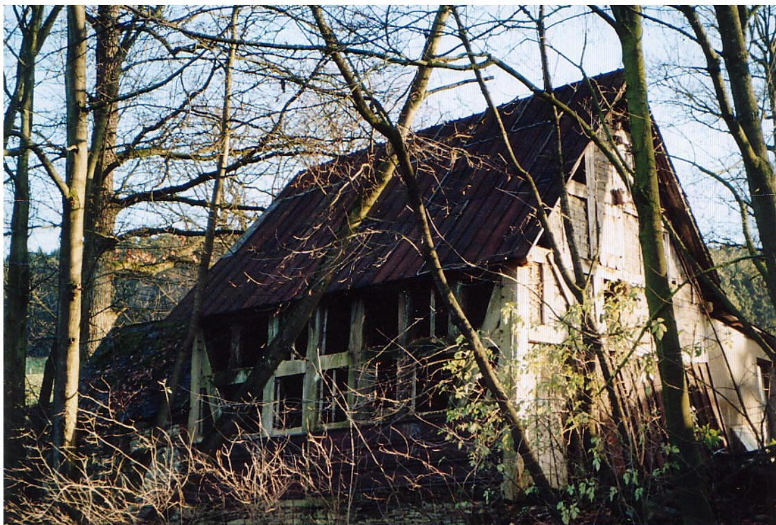
Abb. 48: Backhaus nach vorläufigen Sicherungsmaßnahmen
