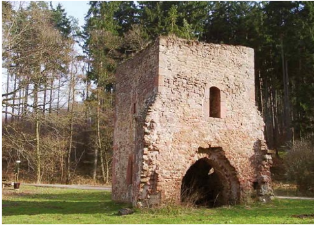
Ruine „Gießlingskirche“ bei Friedewald
